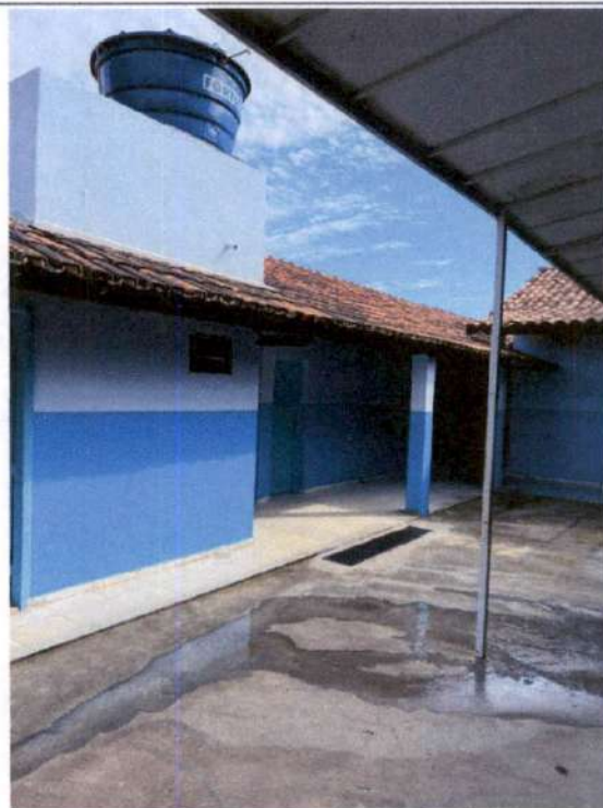
Pintura de paredes internas
