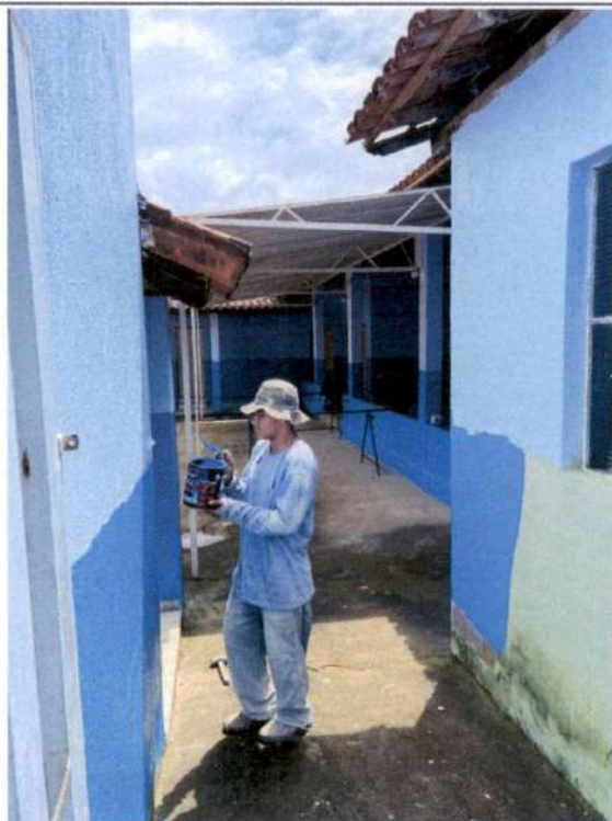
Pintura de corredor de acesso principal
