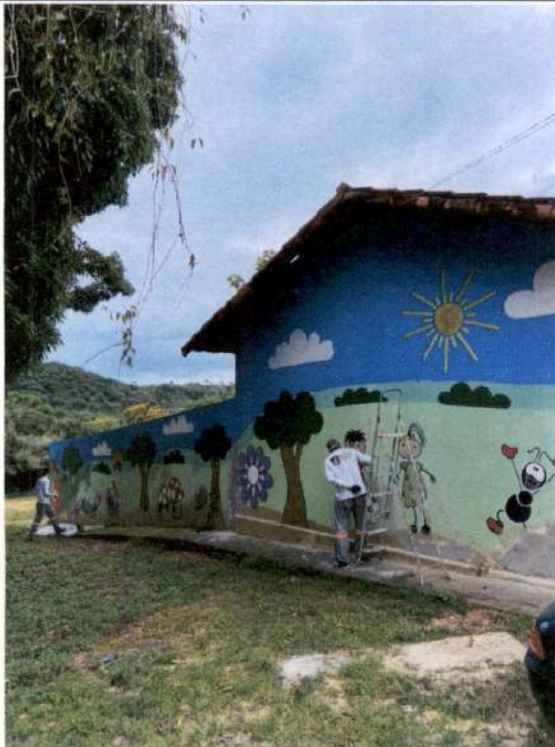
Pintura de fachada frontal
