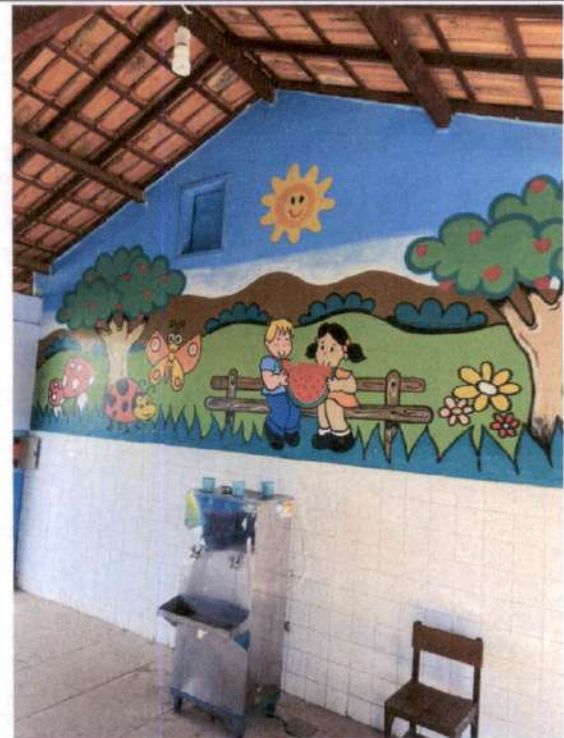
Revitalização de pintura do refeitório
