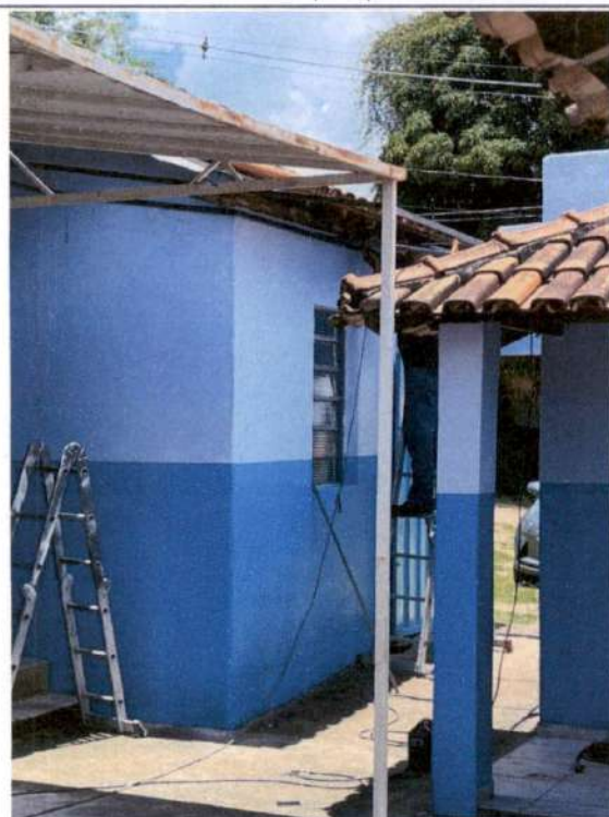
Instalação de estrutura para toldo
