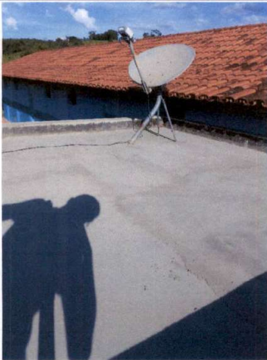
Impermeabilização de laje
