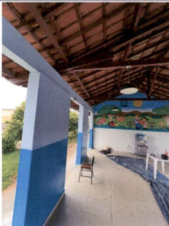
Pintura de paredes internas
