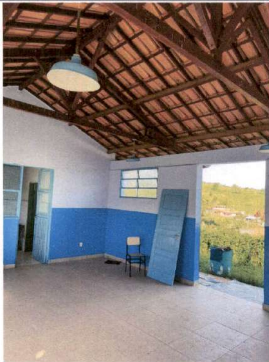
Pintura de paredes internas
