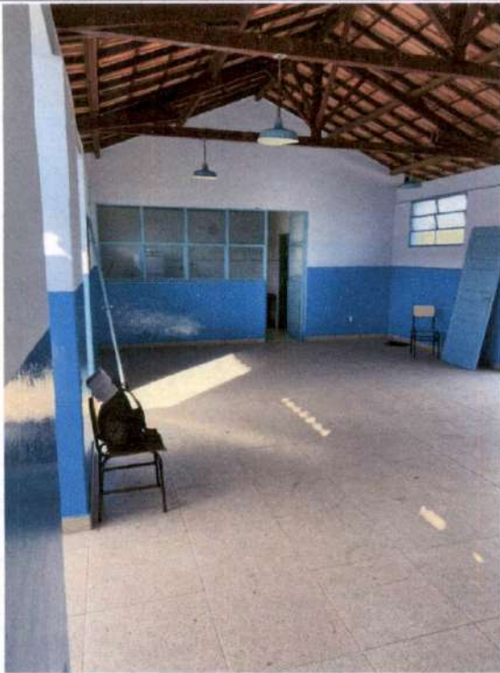
Pintura de paredes internas
