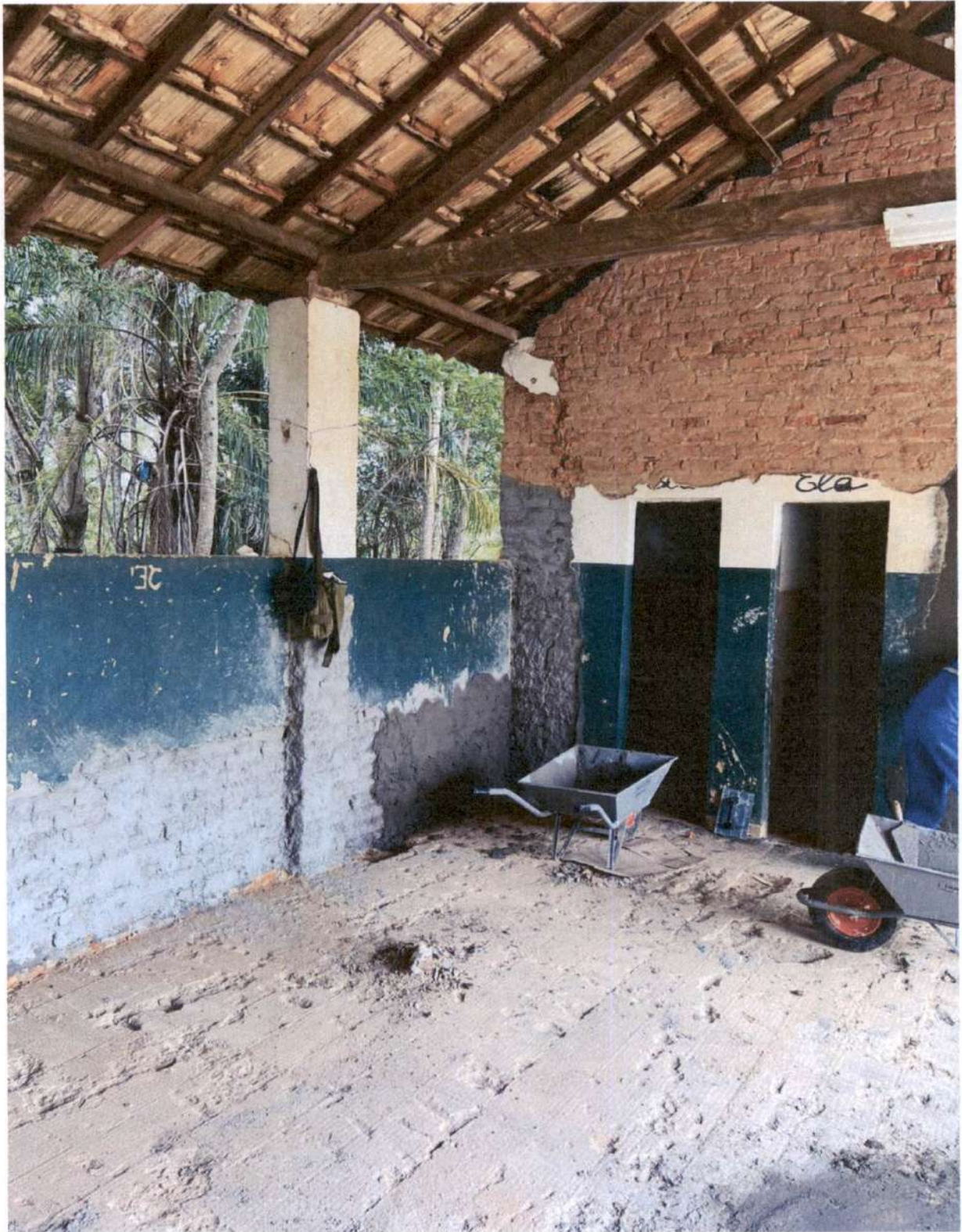
Figura 3 a 13- Recomposição de massa nas paredes e pisos e reforço estrutural (Escola de Sumidoura).
