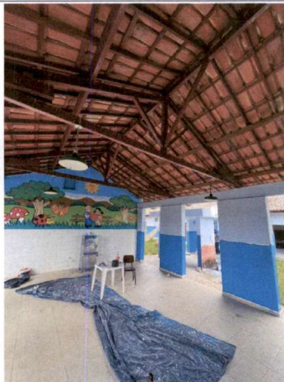
Pintura de paredes internas
