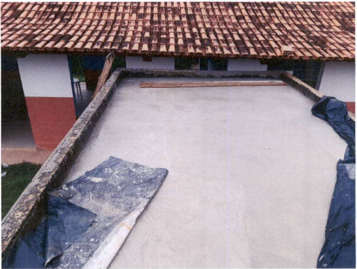
Figura 19- Impermeabilização de laje (Escola de Botafogo).
