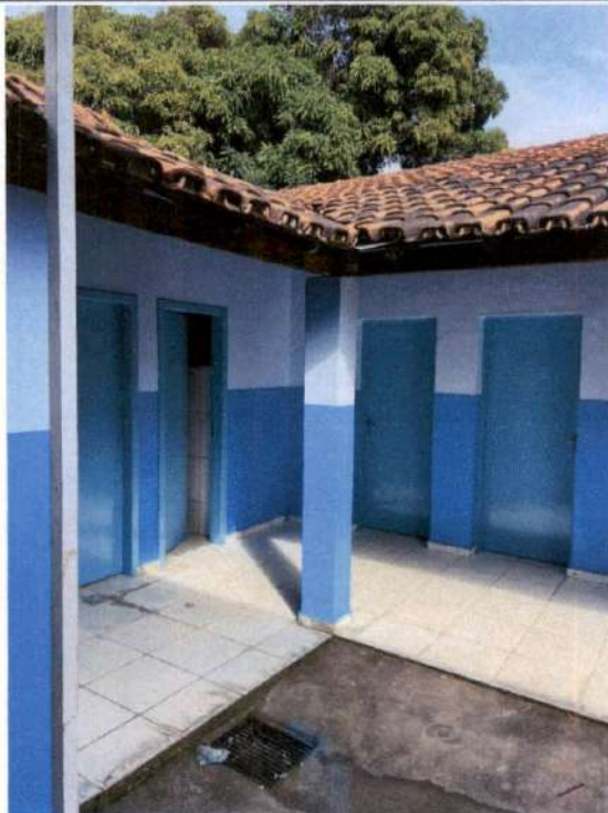
Pintura de paredes e portas
