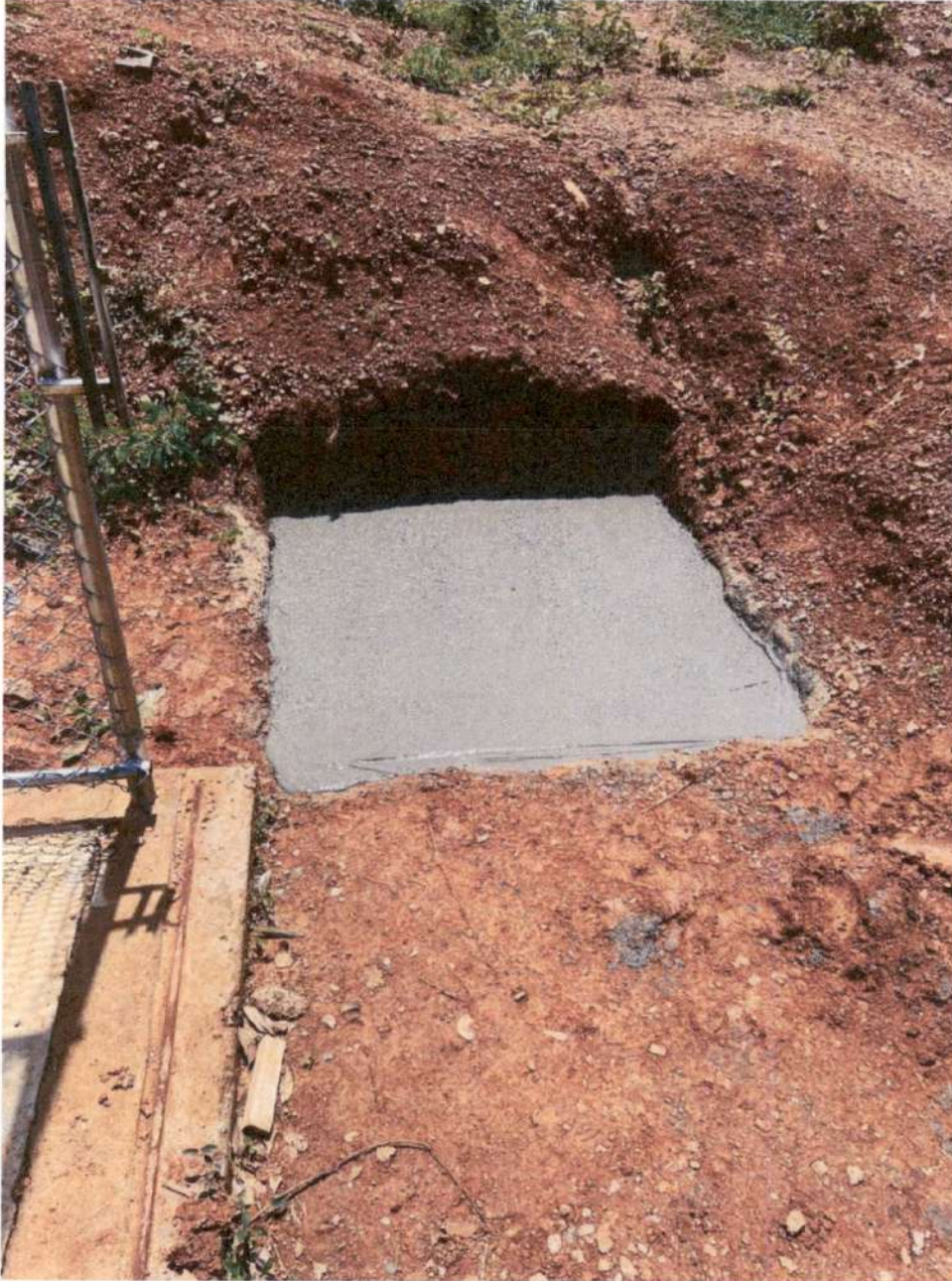
Figura 1 e 2 - Concretagem em bloco de fundação (Quadra Poliesportiva de Mucambo)
