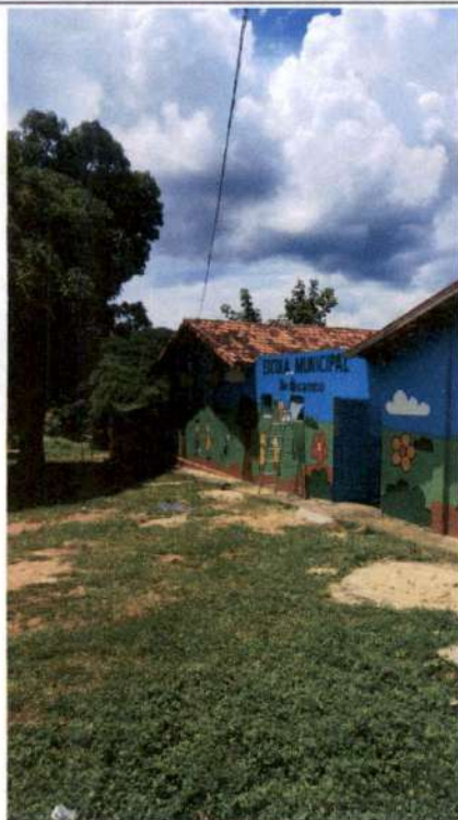
Pintura de fachada
