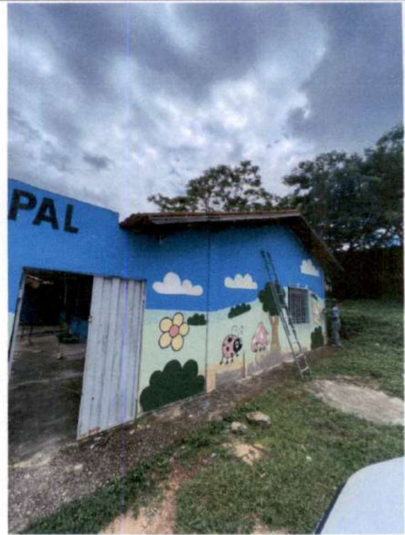
Pintura de fachada frontal
