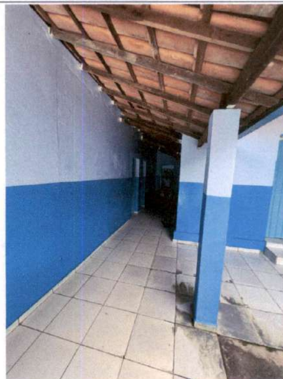
Pintura de paredes internas
