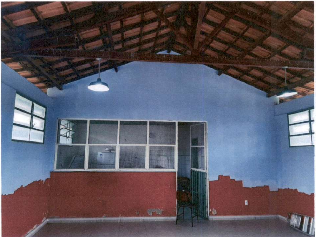
Figura 15a 17- Pintura predial (Escola de Botafogo).
