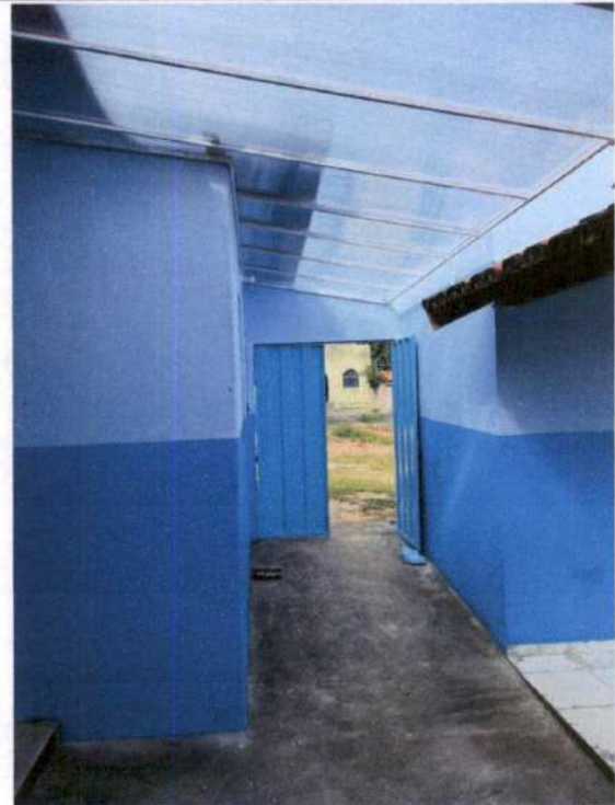
Entrada coberta com toldo em policarbonato
