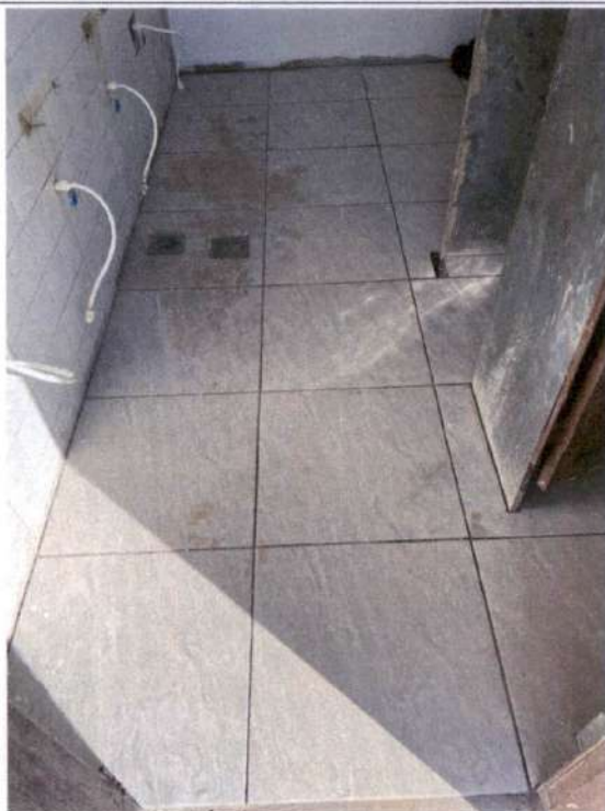
Instalação de sanitários
