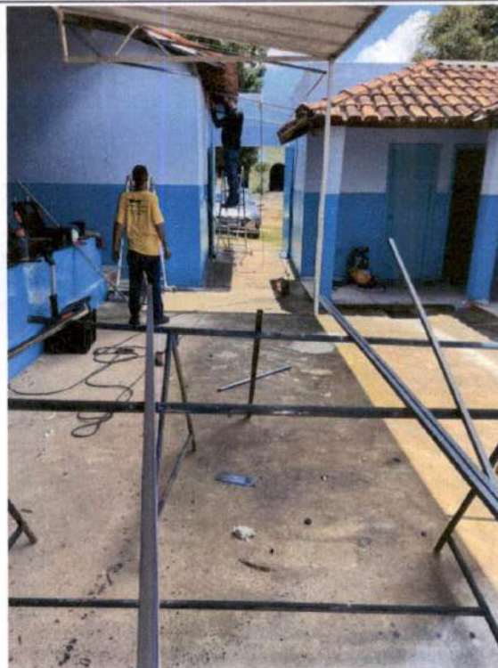
Instalação de estrutura para toldo
