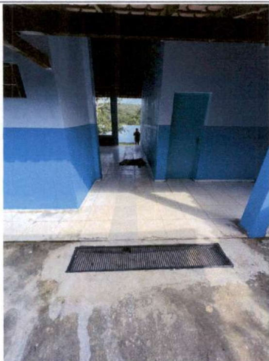
Grelha para escoamento dá água do pátio
