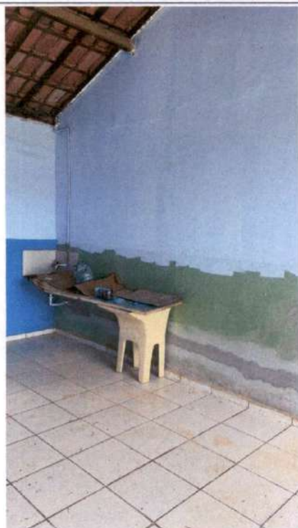
Área de tanque recebendo pintura
